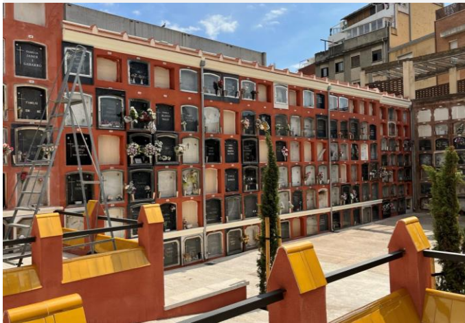
Nitxols rehabilitats al Cementiri de Sants,
