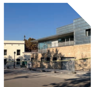
Rehabilitació de l'edifici administratiu i ampliació de l'edifici annex
