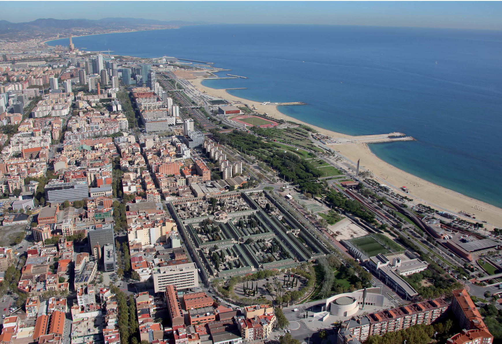
Fotografia aèria del cementiri de Poblenou
